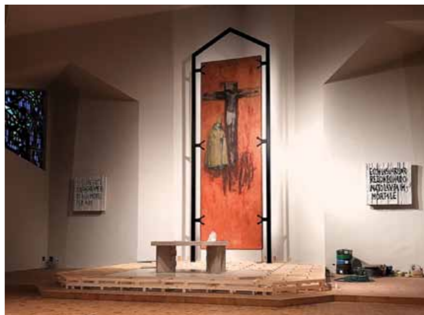
La pedana del presbiterio in costruzione.
